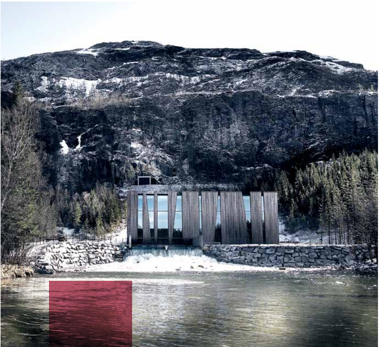
Øvre Forsland hydropower plant. Photo: Helgelandskraft
