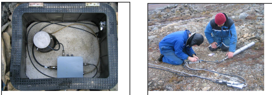
Fig.1 Installering av seismiske sensorer i borehull ved NORSARs seismiske stasjon (SPI) i Adventdalen, Spitsbergen. Borehullene er ca 6m dype, og det er utviklet et sinnrikt system (øverste høyre bilde) for orientering av instrumentene slik at komponentene peker nøyaktig i retningene nord, øst og vertikalt.
